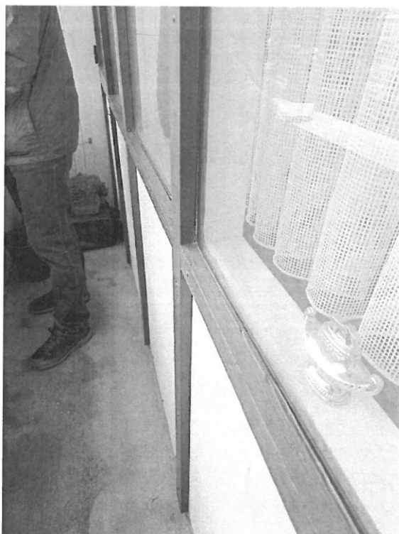
Foto 6: Let facade (oprindelig) der danner klimaskærm mod boligen.
